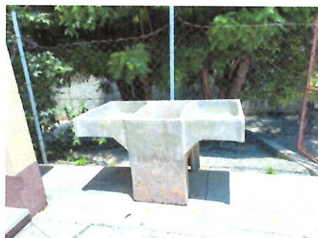
Foto 4: Sustitución pila, nivelada y con conexiones hidráulicas.
