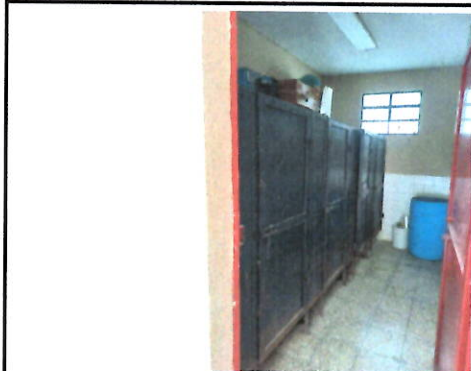
Foto1: Mantenimiento a puertas metálicas existentes retiro de óxido, suciedad y pintura deteriorada; incluye cepillado, lijado y aplicación de pintura, incluyendo las puertas de los sanitarios.
