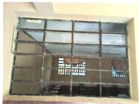
Sustitución de ventanas; sistema de apertura: Corredizas, Perfiles color blanco estandar, Material del marco: PVC Material de la ventana: Vidrio, sellado perimetral.
