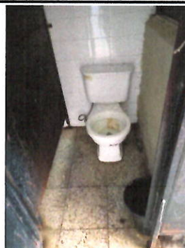
Foto 6: Sustitución de sanitarios lavables, accesorios y conexiones.
